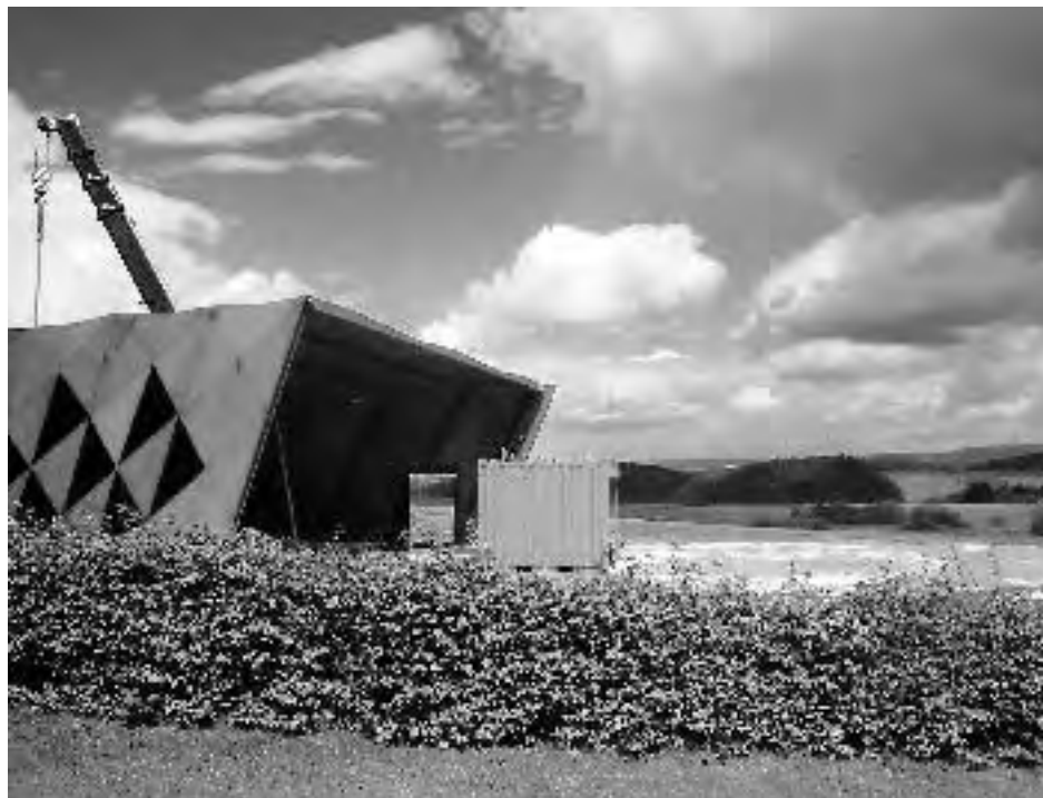
Das Dokumentationszentrum im Rohbau - Fotoarchiv Dieter Burgard
